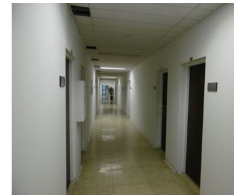
La firme RÝCHLY est établie dans ce couloir froid et impersonnel.
